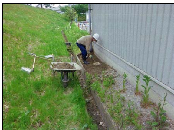
除染(表土剥ぎ取り)
