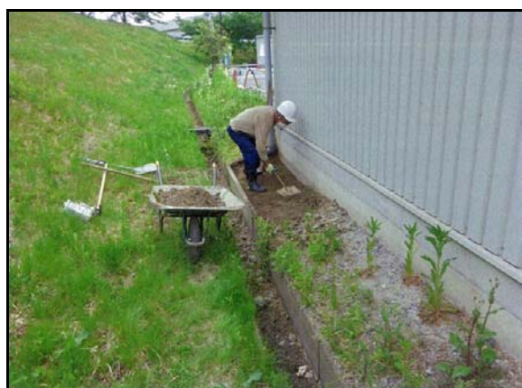
除染(表土剥ぎ取り)
