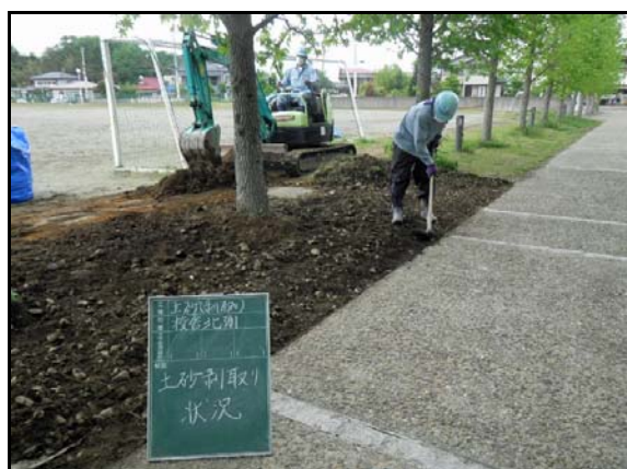
社川小学校除染状況
