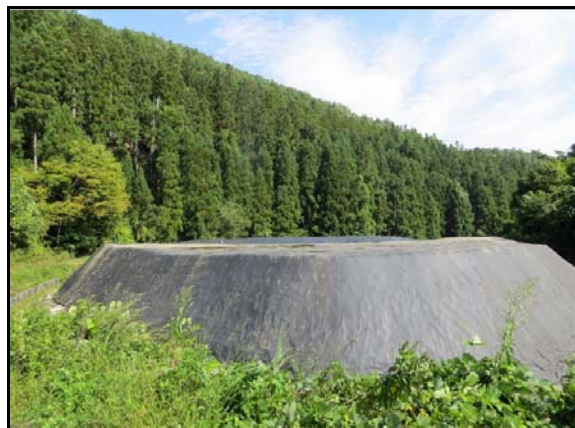
高内仮置場全景
